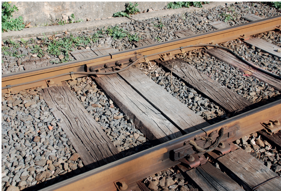
Figure 1 : Un joint éclissé (Source : Jean-Gabriel Ampeau, SNCF Réseau).
