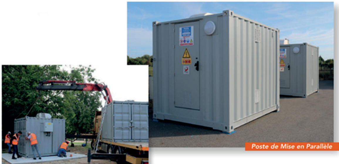
Figure 4 : Poste de mise en parallèle sur la ligne Clermont – Paris (Source: SNCF Réseau).
