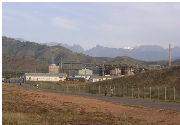
Usine de production de cobalt par biolixiviation (© M. Mugabi)
