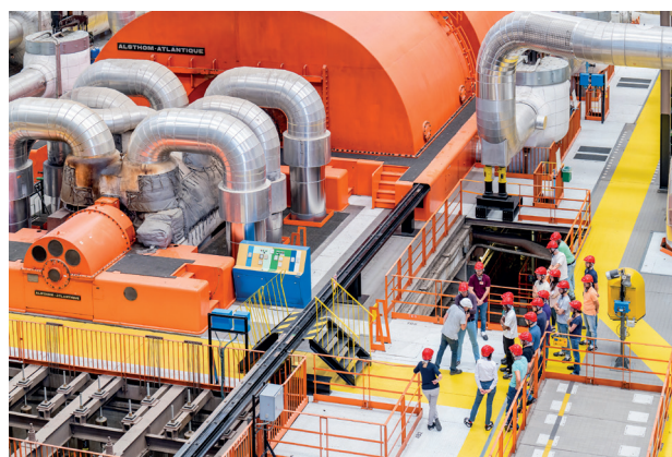
Figure 1 : Visite de la centrale nucléaire de Tricastin (Source : © EDF/Cyril Crespeau).
