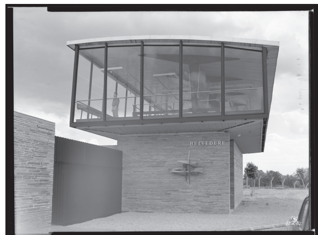
Figure 3 : Chantier du CNPE de Chinon A en juillet 1962, le belvédère (Source : © EDF Archives de Blois/Henri Baranger).
