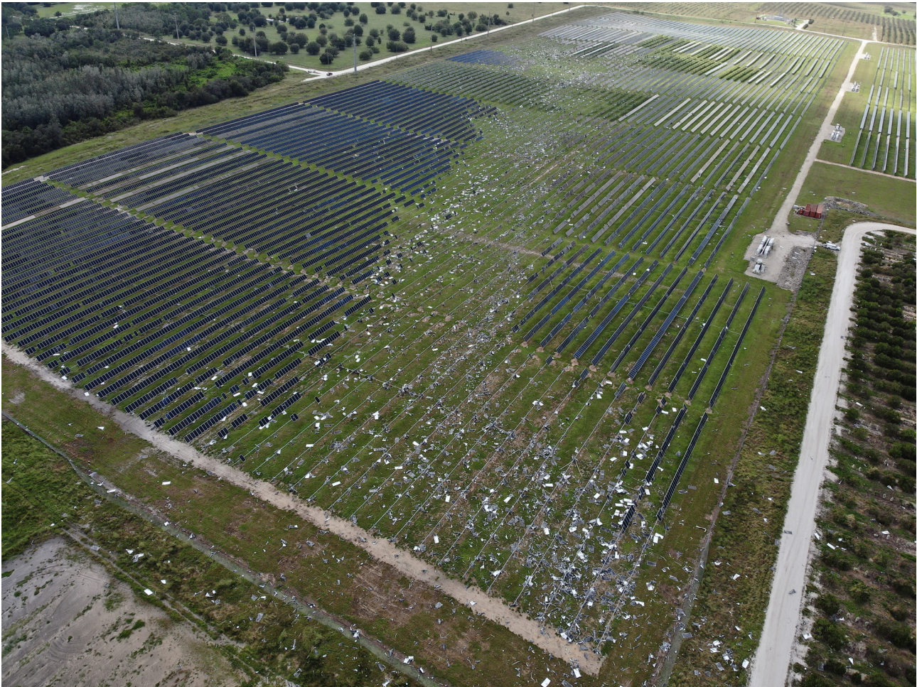
Figure 1 : Dégâts causés par l'ouragan Milton sur le parc solaire Lake Placid aux États-Unis en octobre 2024 (Source : Gallery: Lake Placid (Fla.) Solar | Milton damage | Duke Energy | News Center, https://news.duke-energy.com/multimedia-gallery/photos/hurricane-milton/lake-placid-fla-solar-milton-damage ).
