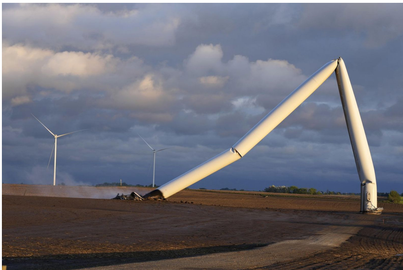
Figure 2 : Éolienne détruite par une tornade dans l'Iowa en mai 2024 (Source : AP Photo/Charlie Neibergall ; Powerful tornado topples wind turbines in US: Experts say such destruction is 'extremely rare' | Euronews, https://www.euronews.com/green/2024/05/23/powerful-tornado-topple-wind-turbines-in-us-experts-say-such-destruction-is-extremely-rar ).
