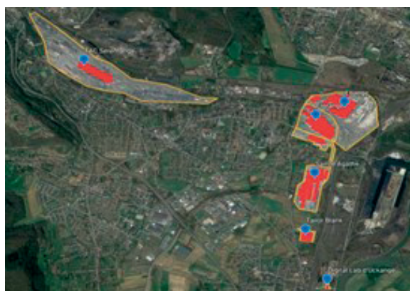
Figure 2 : Délimitation de l'expérimentation sur le site de Florange (Source : ArcelorMittal France).
